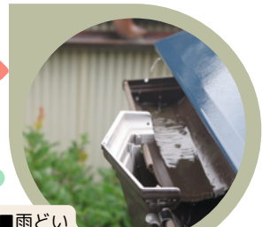
■雨どい 詰りや設置不良がないか
